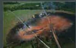
Conséquences d'une fuite sur une canalisation de transport, Apollonia (USA), 14 septembre 2008 (source : public.org).
