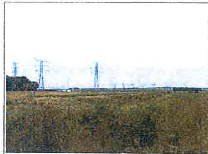
Photographie : réseau électrique du poste d'Argoeuves
